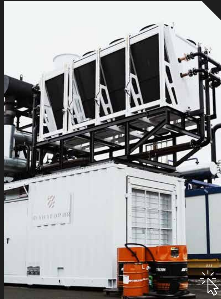
Электростанция 1 МВт для АПФ Фанагория
